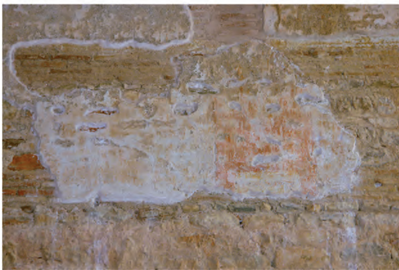
Abb. 44: Apsidensaal 8, Scheitel des Gewölbes
