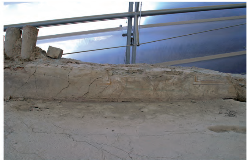
Abb. 52: OG Raum 31aO.1, O-Wand
