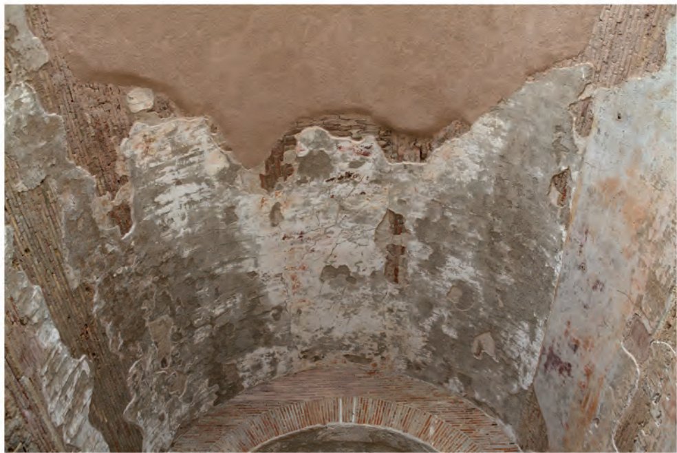
Abb. 43: Apsidensaal 8, westliches Gewölbe
